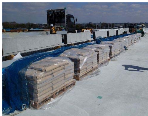
写真-4.5.1 モルタル材の仮置き例
