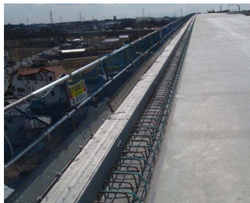
写真-4.1.1 壁高欄工着手前の状況例
