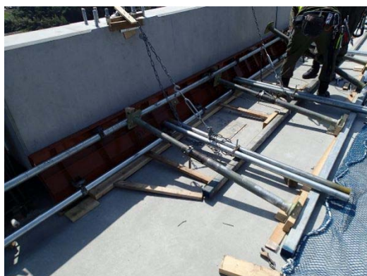
写真-4.4.2 型枠の設置例(1)
