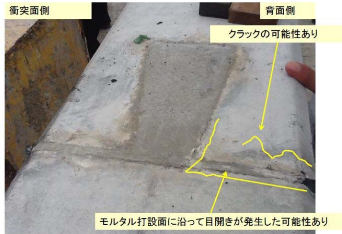
写真-参 5.4 天端接合部の拡大状況
