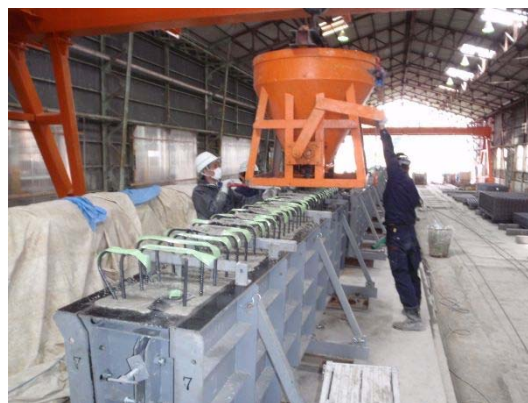
写真-3.4.1 打込み状況例
