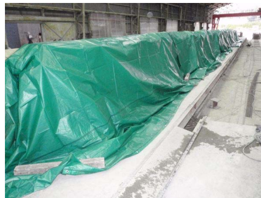
写真-3.4.2 蒸気養生状況例
