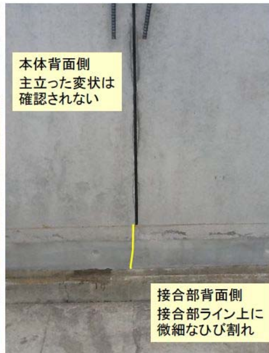
写真-参 5.3 床版接合部の状況
