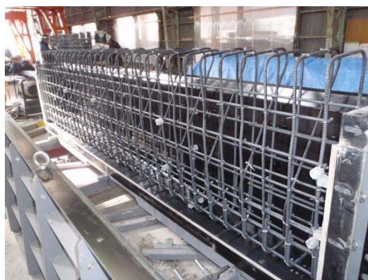
写真-3.2.5 鉄筋ユニットのセット
