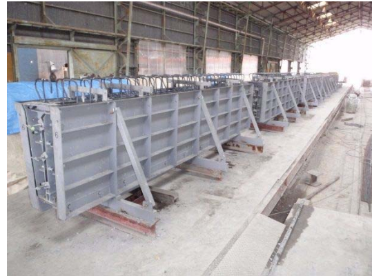
写真-3.2.7 反対側の側型枠の組立て
