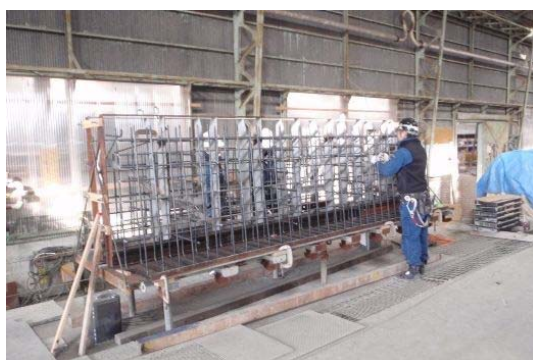
写真-3.2.1 鉄筋組立て状況例
