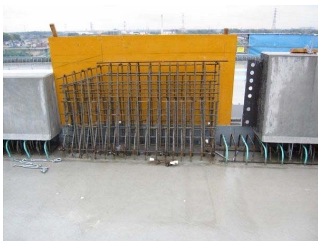
写真-2.6.1 SB種とSS種の擦付け場所打ち部の施工例
