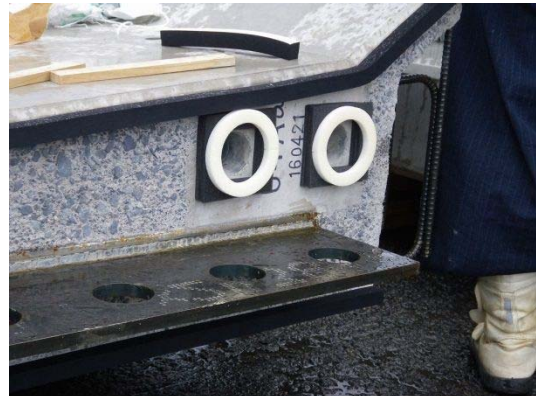
写真-4.2.4 パッキン材の貼付け例
