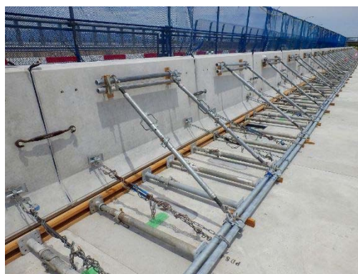
写真-4.4.3 型枠の設置例(2)
