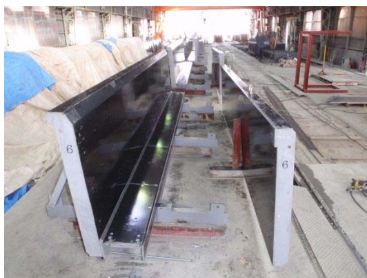
写真-3.2.4 片側の側型枠の組立て
