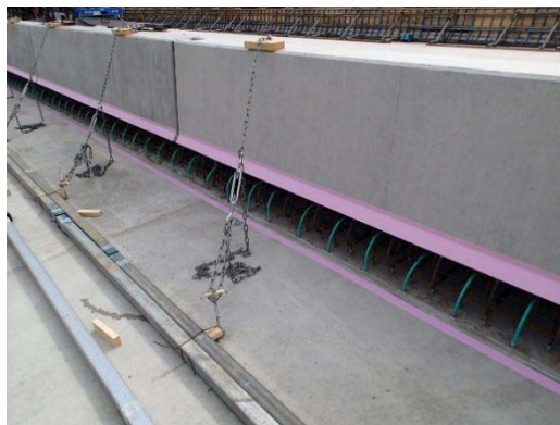
写真-4.4.1 養生テープの貼付け例
