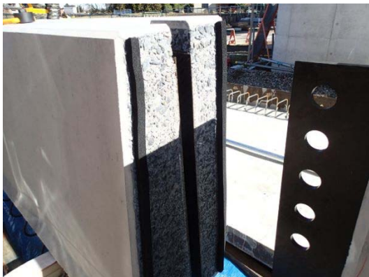
写真-4.2.3 クッション材の貼付け例
