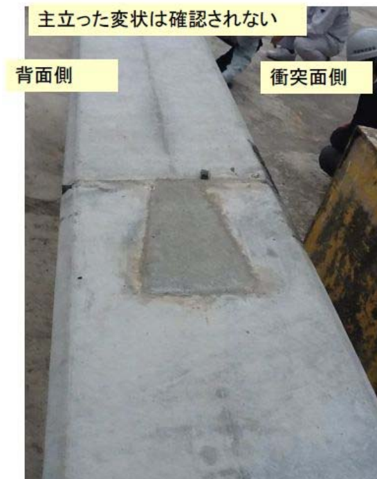
写真-参 5.2 天端接合部の状況
