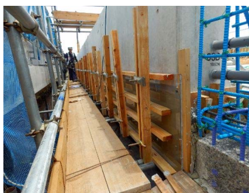
写真-4.6.4 背面型枠の設置例
