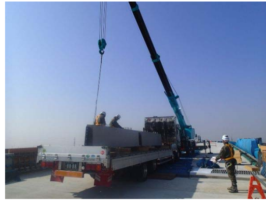
写真-4.2.2 荷卸し状況例
