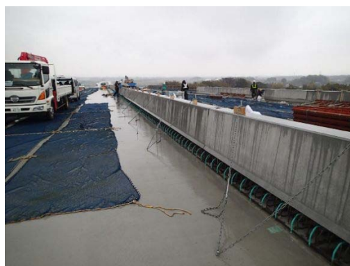
写真-4.2.10 仮固定の状況例
