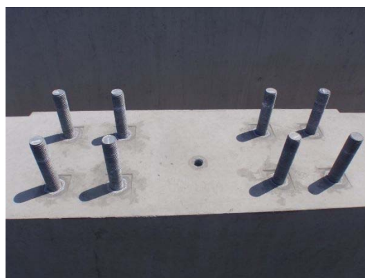
写真-3.2.3 遮音壁アンカーの設置例
