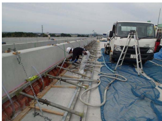
写真-4.6.1 モルタル圧注例
