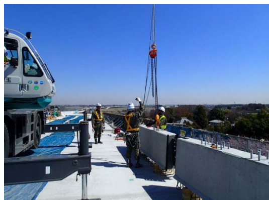
写真-4.2.5 建込み状況例
