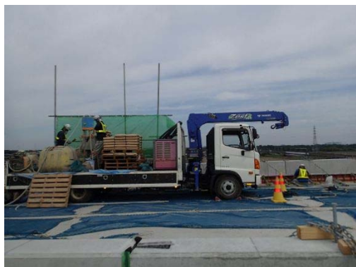
写真-4.5.2 混練り状況
