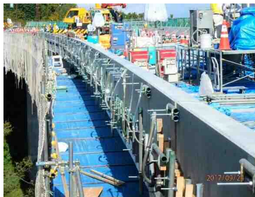
写真-5.6.2 水頭圧掛け状態
