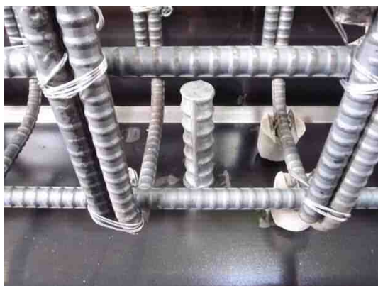
写真-4.2.6 吊インサートの配置
