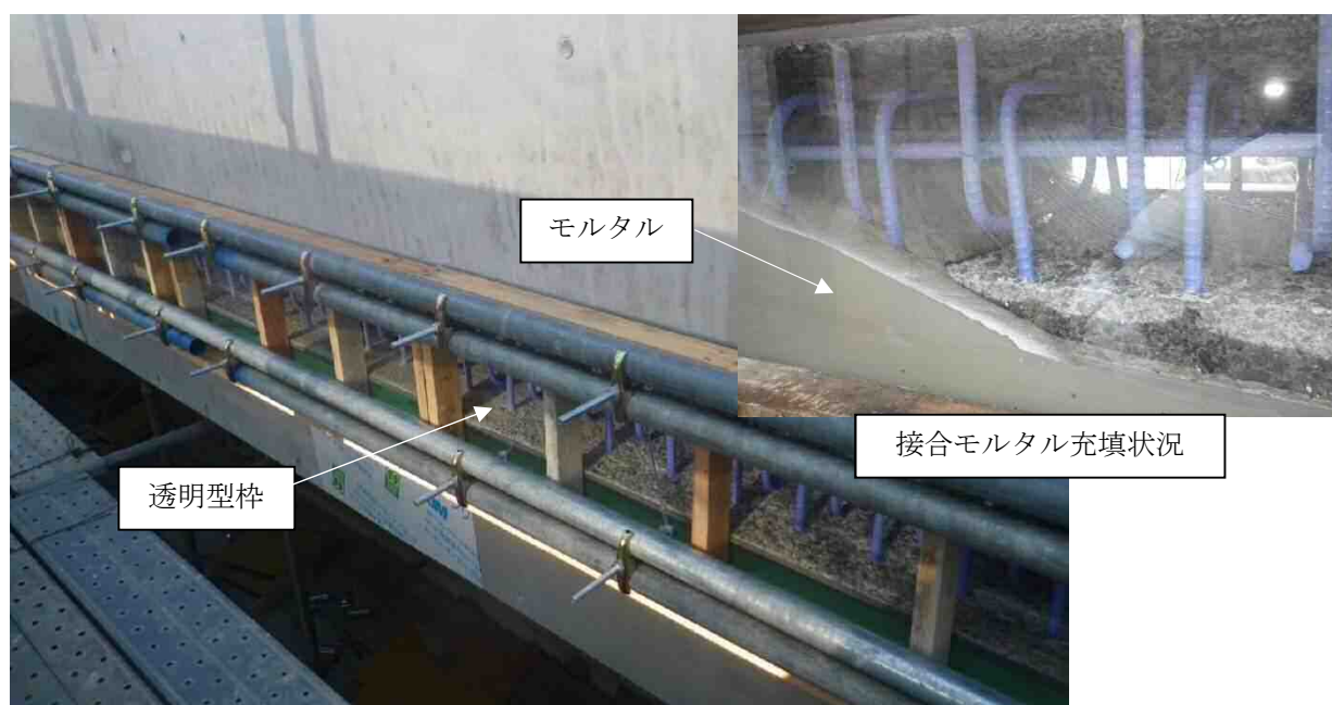
写真-7.2.1 壁高欄背面での透明型枠の設置例
