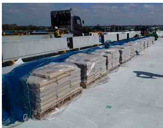
写真-5.5.1 モルタル材の仮置き例
