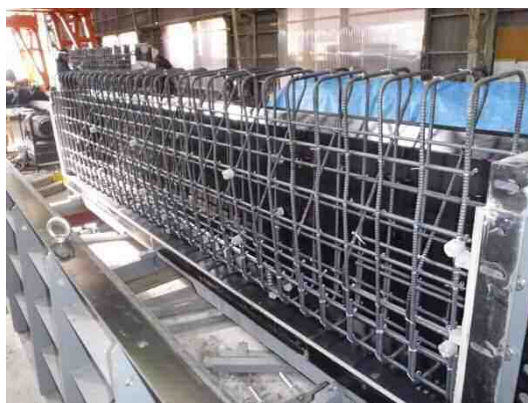
写真-4.2.5 鉄筋ユニットのセット
