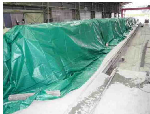
写真-4.4.2 蒸気養生状況例
