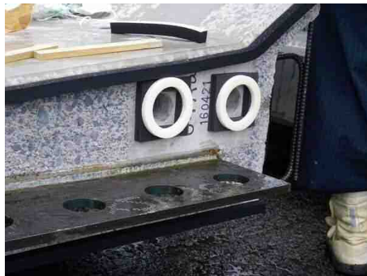
写真-5.2.4 パッキン材の貼付け例
