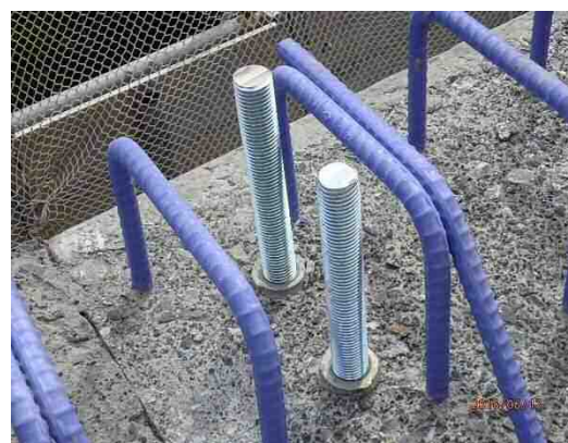
写真-5.2.8 高さ調整用のボルトの設置例
