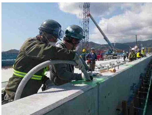
写真-5.6.3 モルタル注入例
