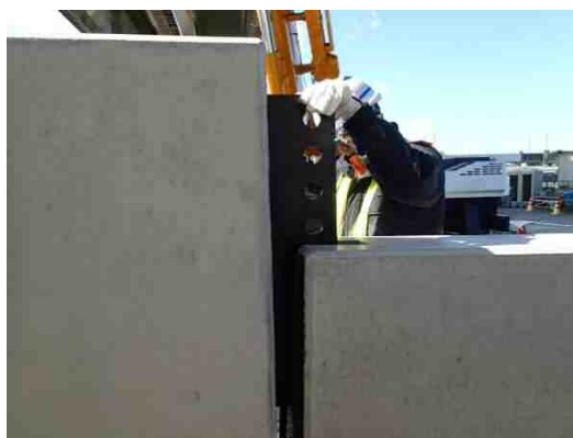
写真-5.2.7 PBL側の落込み状況例
