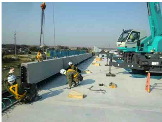
写真-5.2.6 誘導状況例
