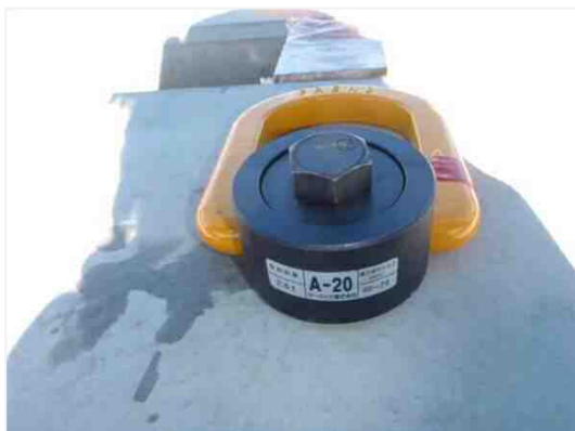
写真-5.2.1 吊上げ治具の例
