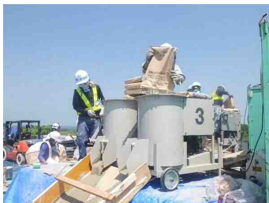
写真-5.5.2 混練り状況例
