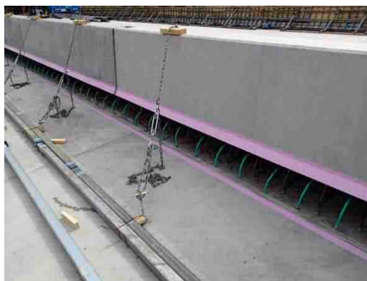
写真-5.4.1 養生テープの貼付け例
