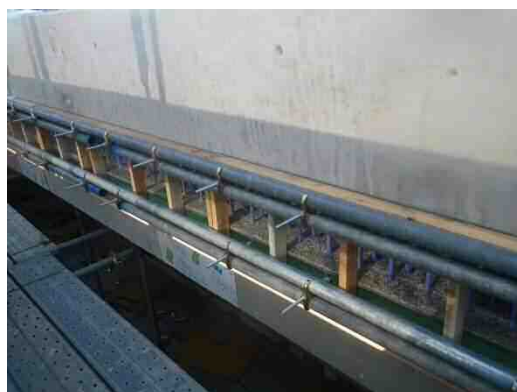
写真-5.6.4 透明型枠の設置例
