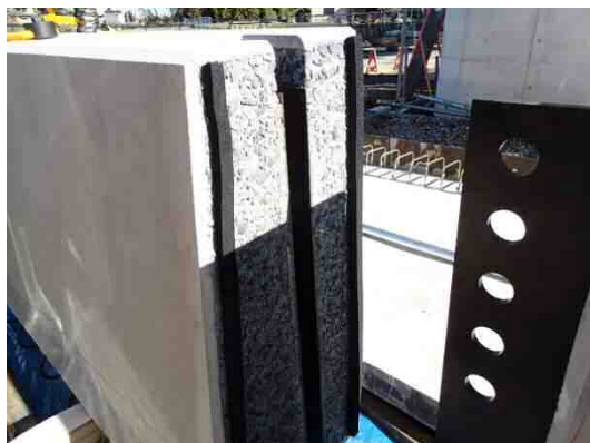
写真-5.2.3 クッション材の貼付け例
