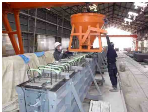
写真-4.4.1 打込み状況例
