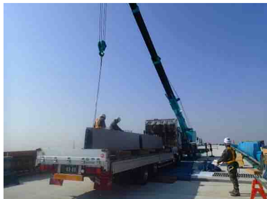
写真-5.2.2 荷下し状況例
