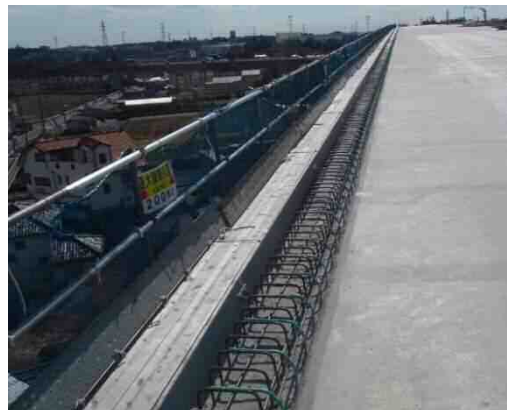
写真-5.1.1 壁高欄工着手前の状況例
