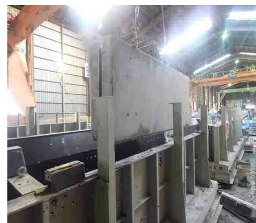
写真-4.5.1 製品の取出し状況例
