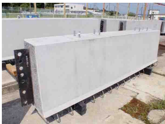
写真-4.6.1 立置き保管状況例
