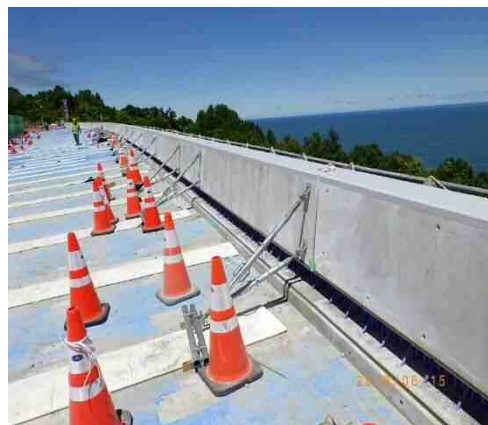
写真-5.2.11 仮固定の状況例
