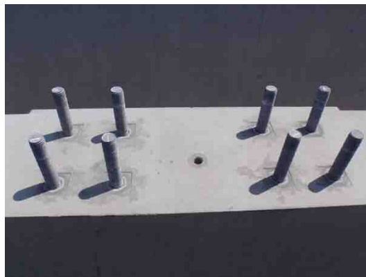
写真-4.2.3 遮音壁アンカーの設置例
