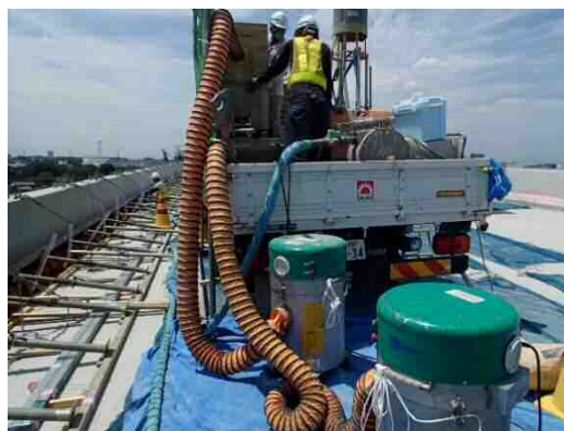
写真-5.5.3 超微細粉塵対策型集塵機の例
