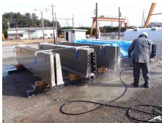
写真-4.5.2 小口面の洗出し状況例
