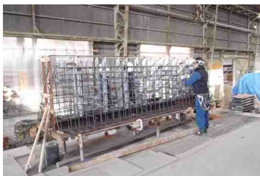
写真-4.2.1 鉄筋組立て状況例
