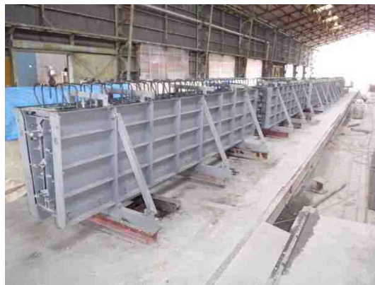
写真-4.2.7 反対側の側型枠の組立て
