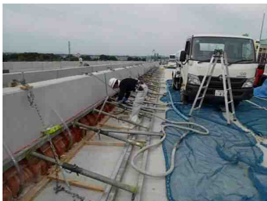
写真-5.6.1 モルタル圧注例
