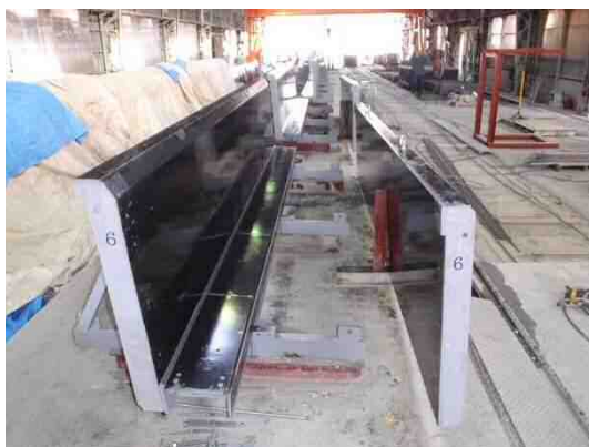
写真-4.2.4 片側の側型枠の組立て
