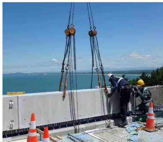
写真-5.2.5 建込み状況例
