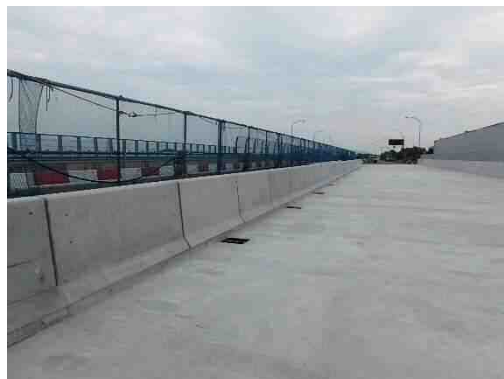
写真-5.8.1 完成状況例
