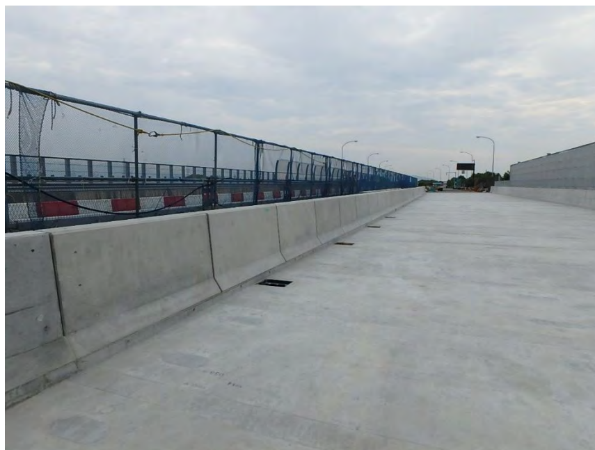
写真-5.8.1 完成状況例
