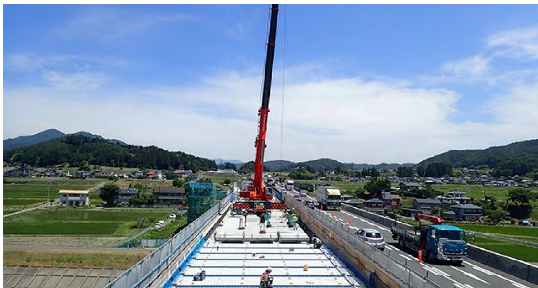
写真-6.1.1 更新事業の施工例
