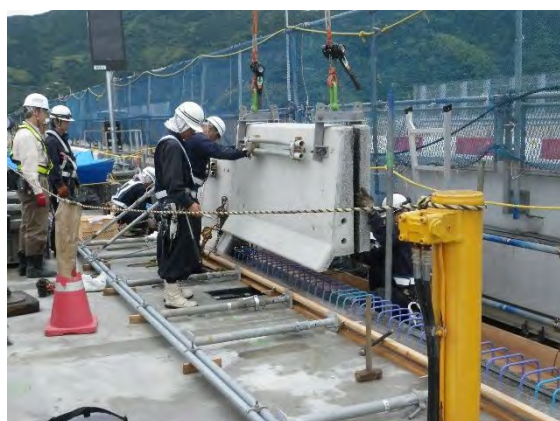
写真-5.2.4 建込み時の状況例
