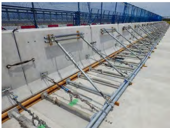
写真-5.4.1 前面型枠の設置例
