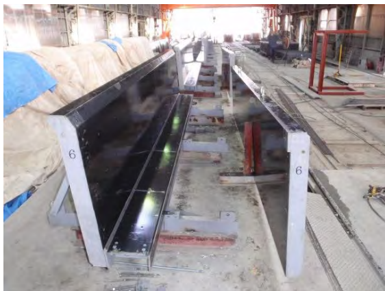
写真-4.3.4 片側の側型枠の組立て状況例
