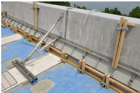
写真-5.6.3 前面型枠設置状況例
