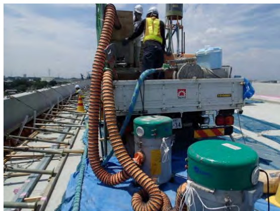
写真-5.5.3 超微細粉塵対策型集塵機の例
