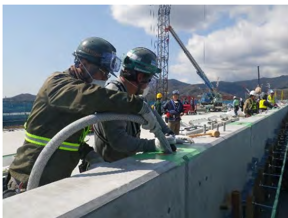
写真-5.6.1 壁高欄天端からのモルタル注入例 写真-5.6.2 透明型枠による充填確認状況例
