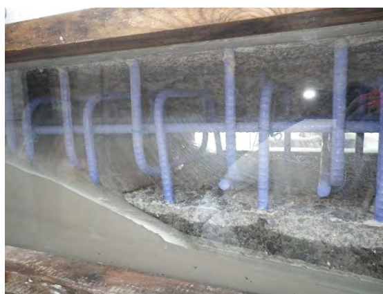
写真-5.6.1 壁高欄天端からのモルタル注入例 写真-5.6.2 透明型枠による充填確認状況例
