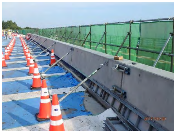
写真-5.4.4 前面型枠の設置状況例
