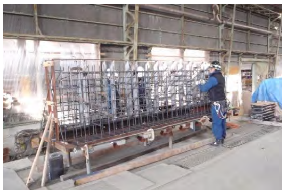
写真-4.3.1 鉄筋組立て状況例
