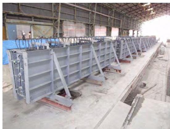
写真-4.3.6 反対側の側型枠の組立て状況例
