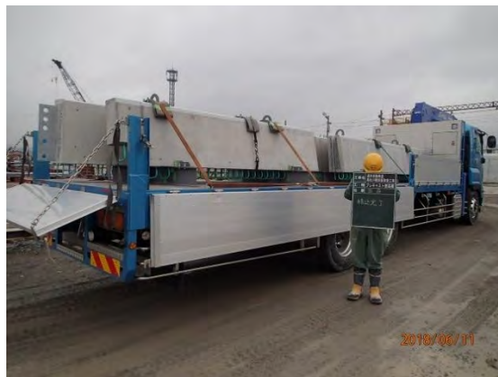
写真-4.11.2 立て置き搬出状況例
