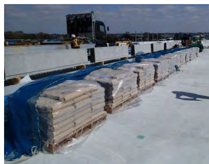
写真-5.5.1 モルタル材の仮置き例
