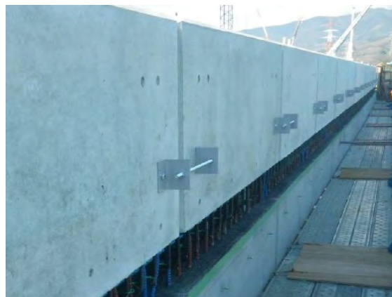
写真-5.2.11 背面の仮固定の施工例
