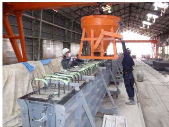
写真-4.7.1 コンクリートの打込み状況例
