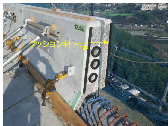
写真-5.2.5 建込み後の状況例
