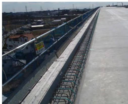
写真-5.1.1 壁高欄工着手前の状況例
