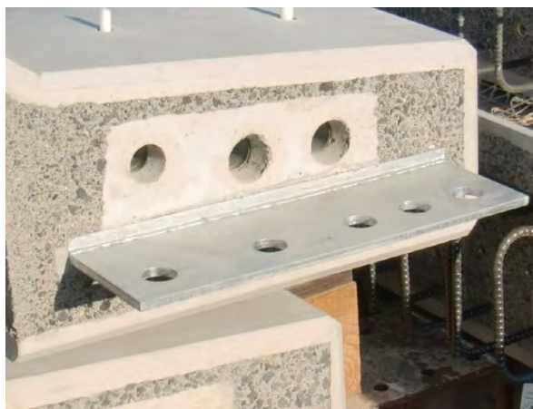
写真-4.9.3 孔あき鋼板の亜鉛メッキ塗装例
