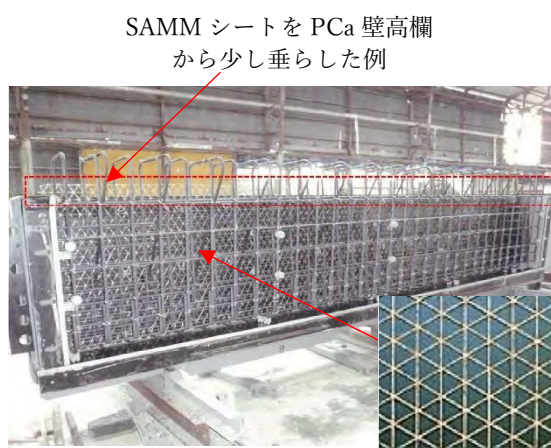
写真-4.4.1 SAMM シートの配置例
