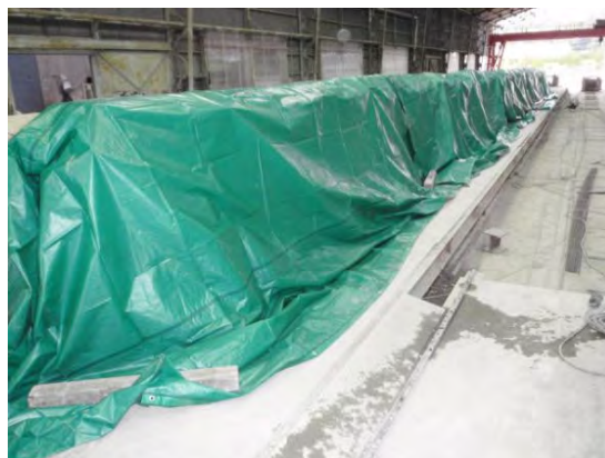
写真-4.7.2 蒸気養生状況例
