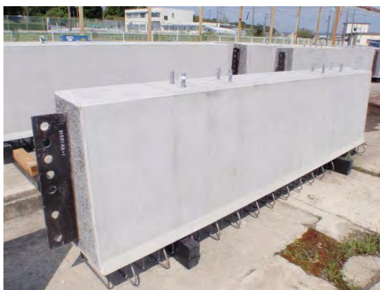
写真-4.9.2 立置き保管状況例
