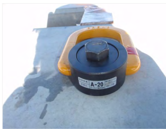
写真-5.2.2 天端吊りの治具の設置例
