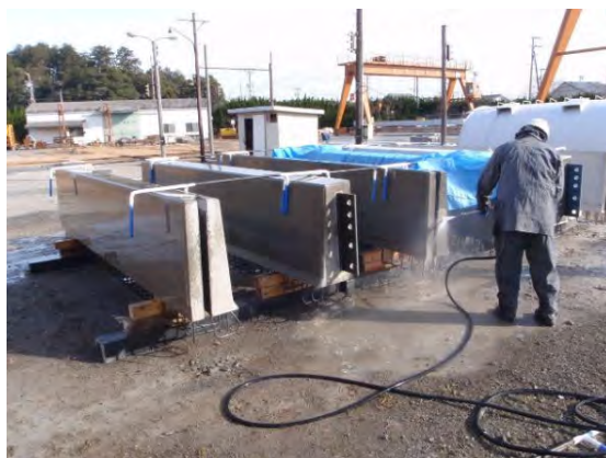
写真-4.8.2 小口面の洗出し状況例
