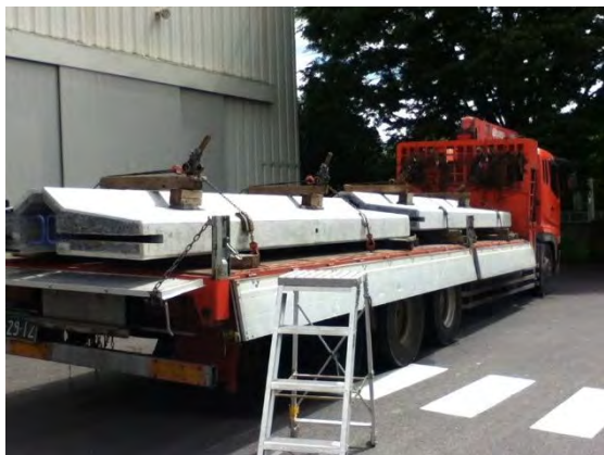
写真-4.11.1 平置き搬出状況例
