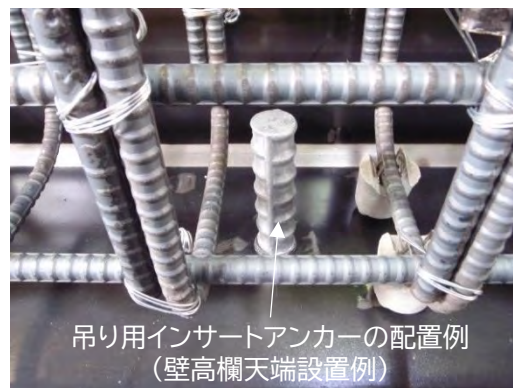
写真-4.3.3 吊り用インサートアンカーの設置例
