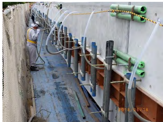
写真-5.6.4 水頭圧を掛けた状況例
