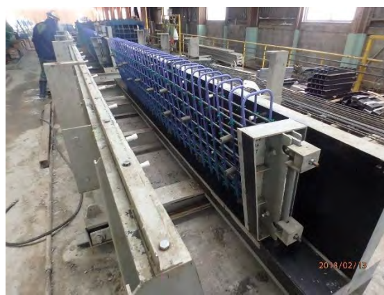
写真-4.3.5 鉄筋ユニットの配置状況例
