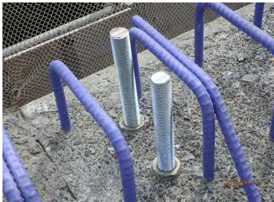
写真-5.2.7 床版側にねじ切りを設けた例
