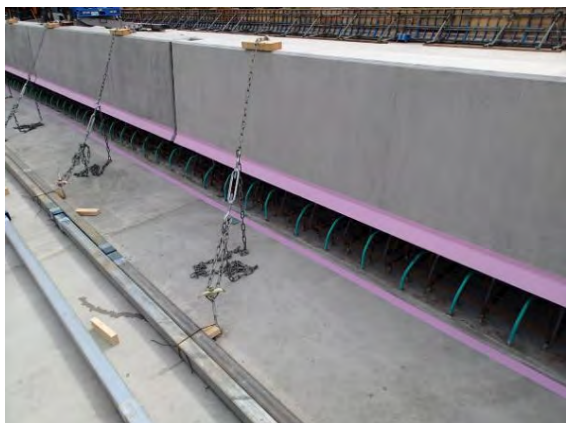
写真-5.4.3 モルタル漏れ防止用テーピングの例
