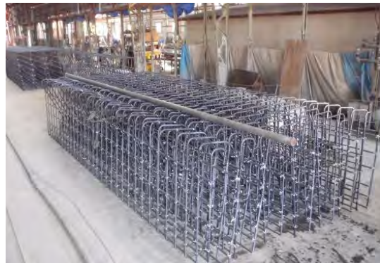
写真-4.3.2 鉄筋ユニットのストック状況例
