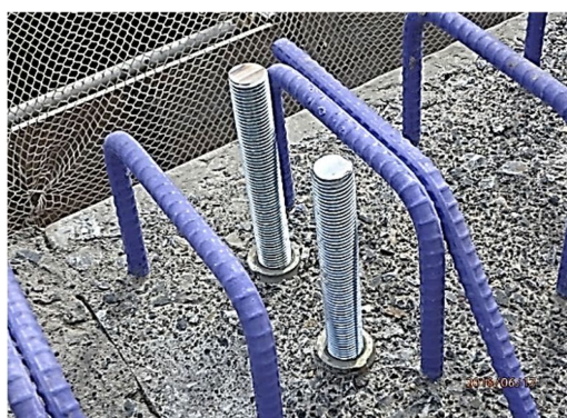
写真-7.2.6 床版側にねじ切りを設けた例
