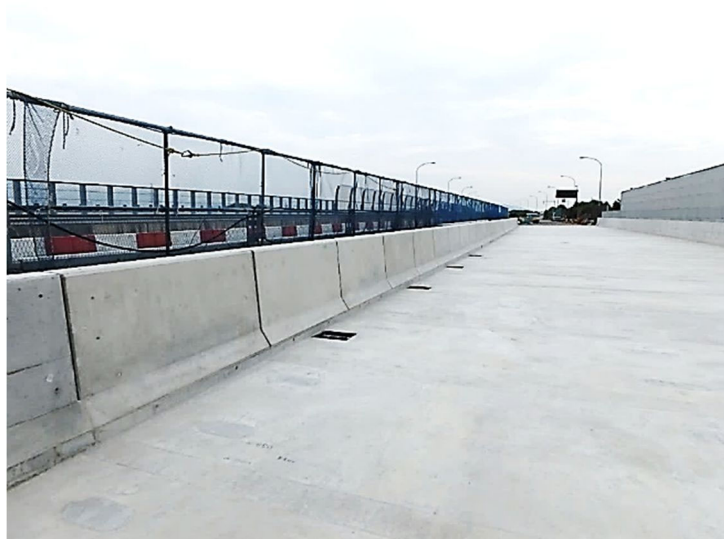
写真-7.8.1 完成状況
