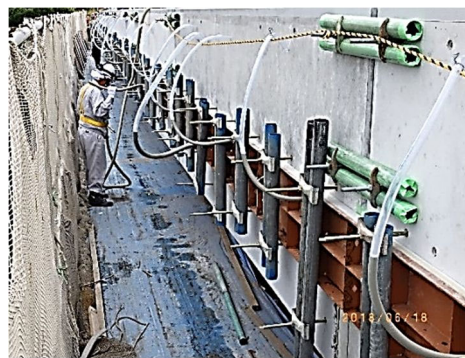
写真-7.6.4 水頭圧を掛けた状況例
