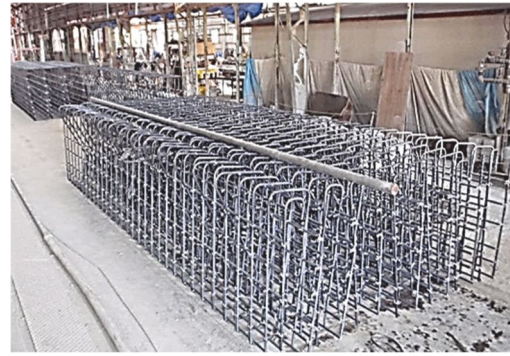
写真-6.3.2 ユニット鉄筋のストック状況例
