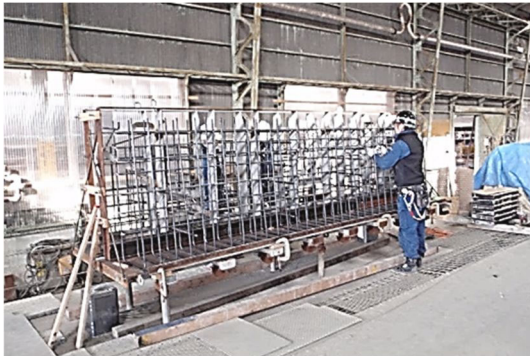
写真-6.3.1 鉄筋の組立て状況例
