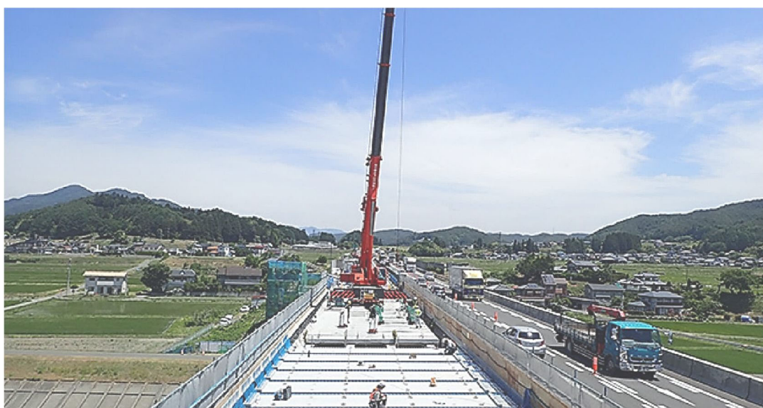
写真-8.1.1 更新こと業の施工例
