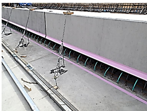
写真-7.4.3 モルタル漏れ防止用テーピングの例 写真-7.4.4 前面型枠の設置状況例
