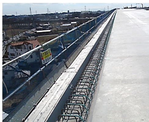
写真-7.1.1 壁高欄工着手前の状況例
