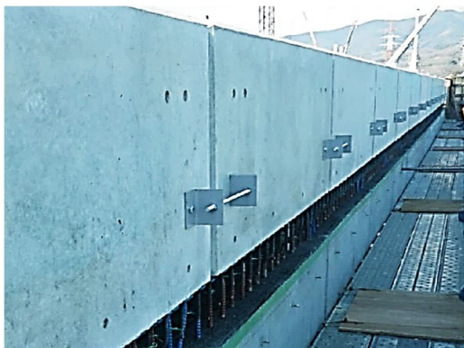
写真-7.2.10 背面の仮固定の施工例
