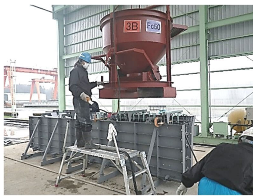
写真-6.2.2 コンクリート打込み時の型枠例
