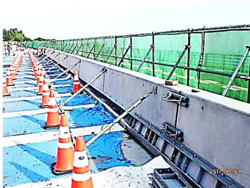
写真-7.4.3 モルタル漏れ防止用テーピングの例 写真-7.4.4 前面型枠の設置状況例
