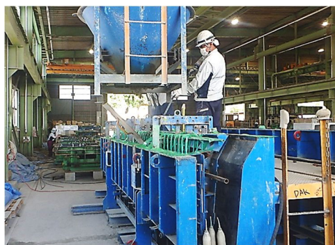
写真-6.9.1 コンクリート打込み状況
