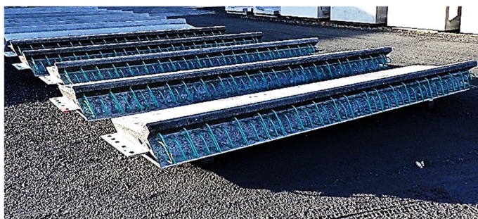
写真-6.12.1 平置き保管状況例
