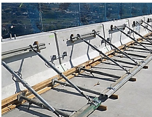
写真-7.2.9 前面の仮固定の施工例
