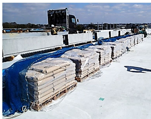
写真-7.5.1 モルタル材の仮置き例
