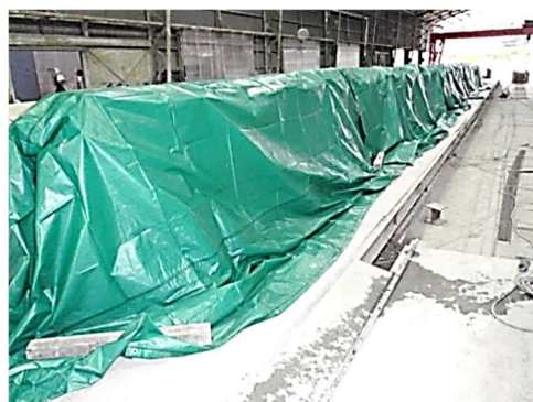
写真-6.9.2 蒸気養生状況例
