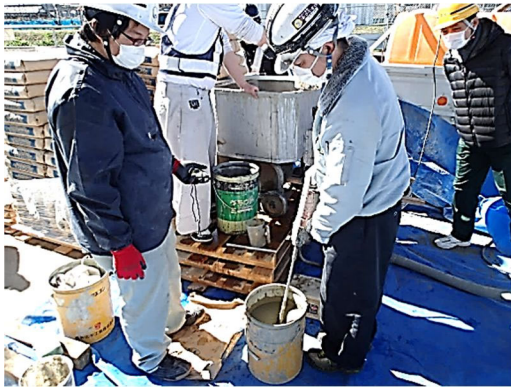
写真-7.3.1 試験練りの状況例
