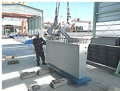
写真-6.10.1 製品の取出し状況例
