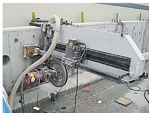
写真-9.2.1 鉛直切断の状況例
