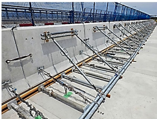
写真-7.4.1 前面型枠の設置例
