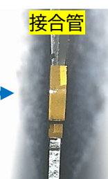
写真-7.2.12 正しい接合管の配置状況
