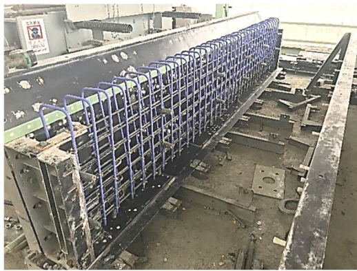
写真-6.2.1 鉄筋配置時の型枠例
