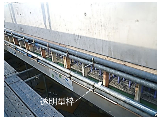
写真-7.4.2 背面透明型枠の設置例
