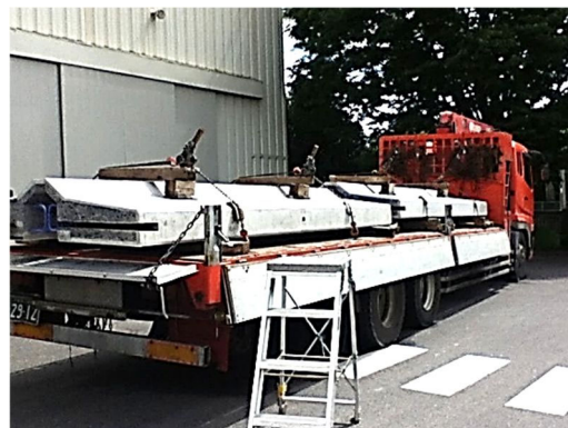
写真-6.14.1 平置き搬出状況例
