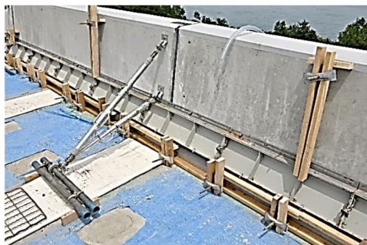
写真-7.6.3 前面型枠設置状況例
