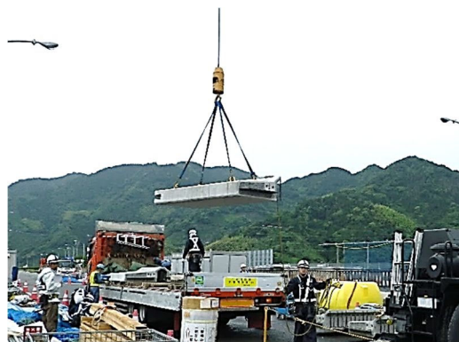
写真-7.2.1 現場到着後の荷下ろし状況の例
