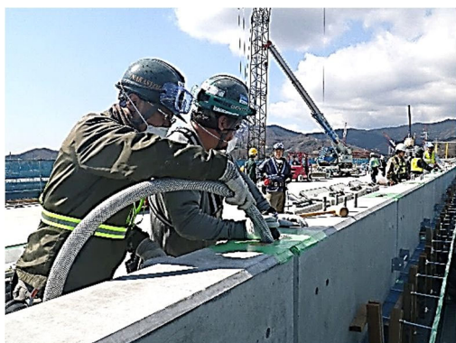
写真-7.6.1 壁高欄天端からの充填例
