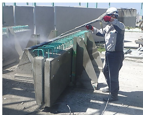
写真-6.10.2 小口面等の洗出し状況例
