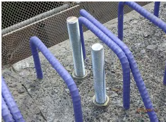
写真-5.2.7 床版側にねじ切りを設けた例
