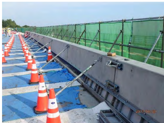
写真-5.4.4 前面型枠の設置状況例
