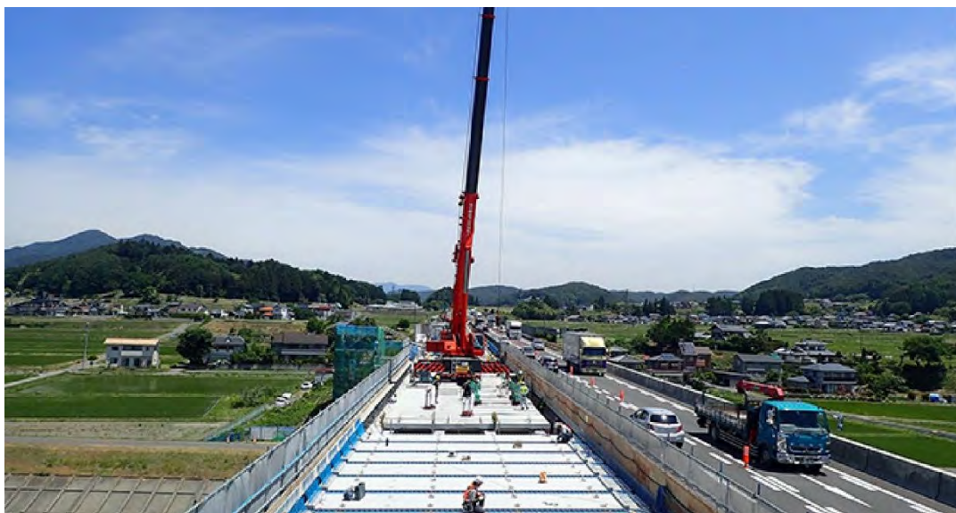
写真-6.1.1 更新事業の施工例
