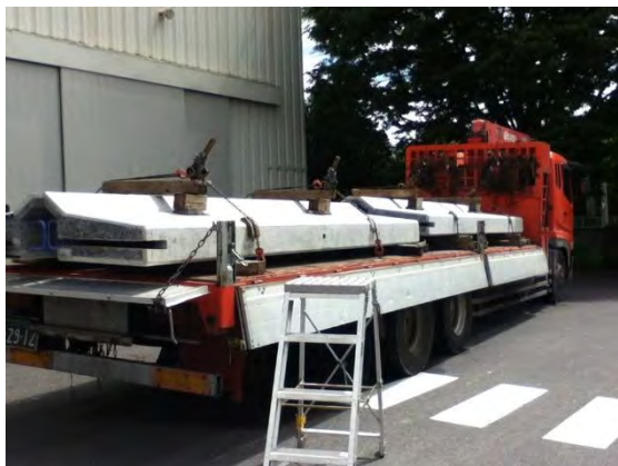
写真-4.11.1 平置き搬出状況例
