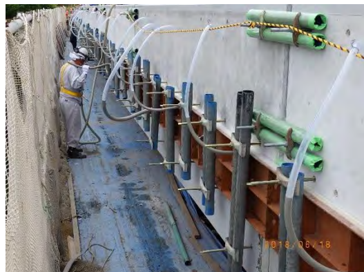
写真-5.6.4 水頭圧を掛けた状況例
