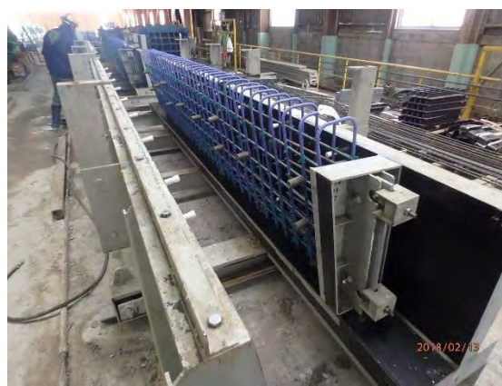
写真-4.3.5 鉄筋ユニットの配置状況例
