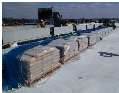
写真-5.5.1 モルタル材の仮置き例
