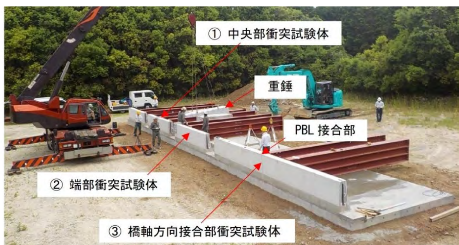
写真-3.6.1 DAK 式壁高欄の衝突試験時の全景
