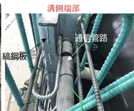
写真-4.5.2 バネ式通信管路端部配置例
