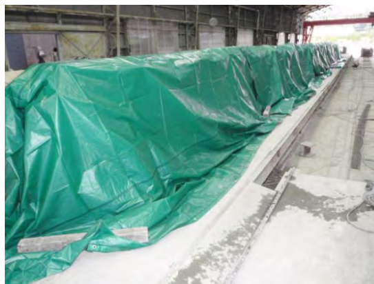
写真-4.7.2 蒸気養生状況例
