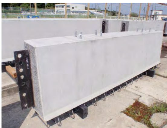
写真-4.9.2 立置き保管状況例
