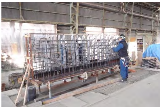
写真-4.3.1 鉄筋組立て状況例
