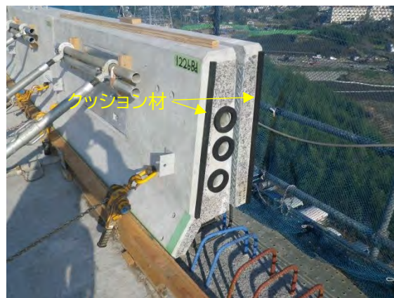
写真-5.2.5 建込み後の状況例
