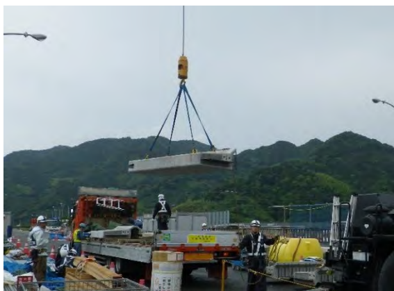
写真-5.2.1 荷下ろし状況の例
