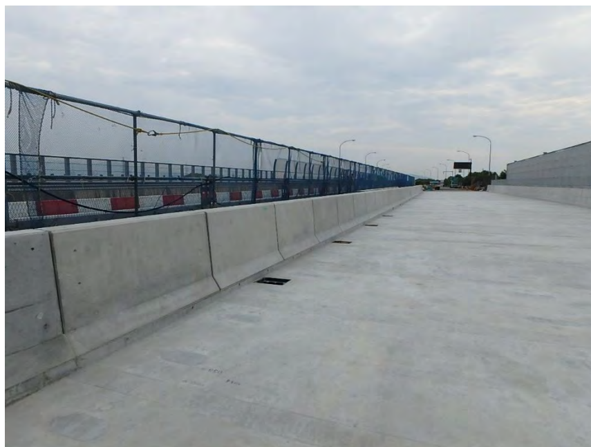
写真-5.8.1 完成状況例
