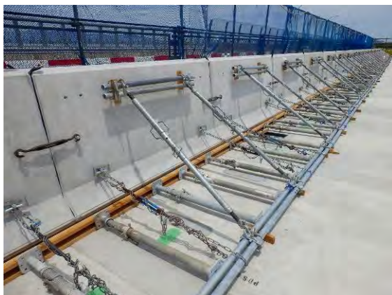
写真-5.4.1 前面型枠の設置例
