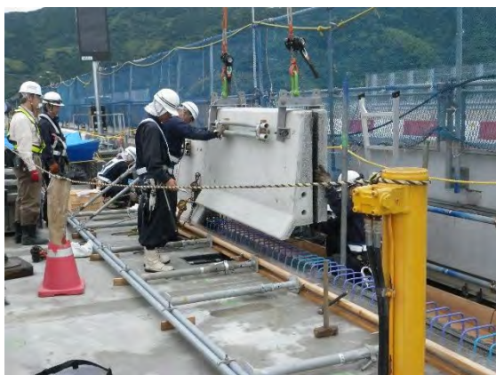
写真-5.2.4 建込み時の状況例
