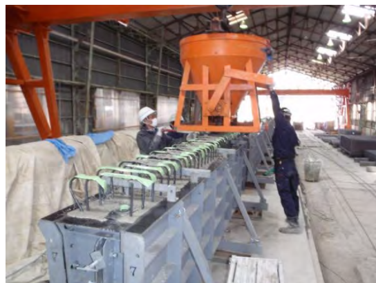
写真-4.7.1 コンクリートの打込み状況例
