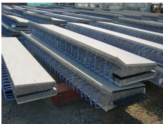
写真-4.9.1 平置き保管状況例
