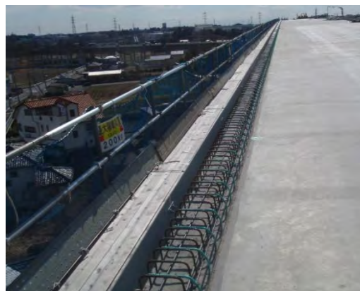
写真-5.1.1 壁高欄工着手前の状況例
