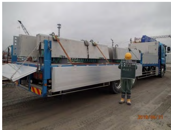
写真-4.11.2 立て置き搬出状況例
