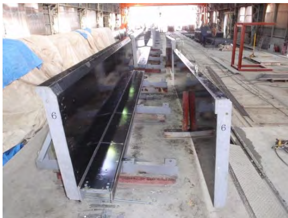
写真-4.3.4 片側の側型枠の組立て状況例
