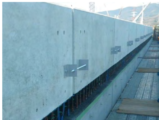
写真-5.2.11 背面の仮固定の施工例
