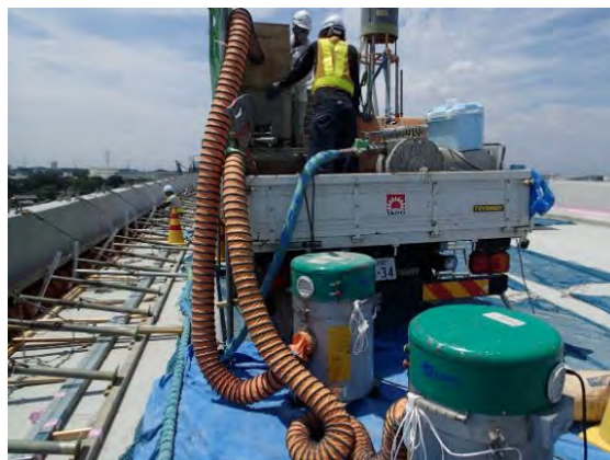
写真-5.5.3 超微細粉塵対策型集塵機の例
