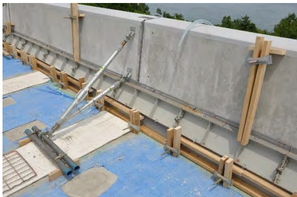
写真-5.6.3 前面型枠設置状況例
