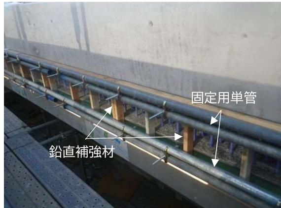
写真-1.2.2 背面透明型枠の設置状況例
