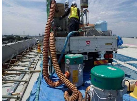
写真-2.3.2 超微細粉塵対策型集塵機の例
