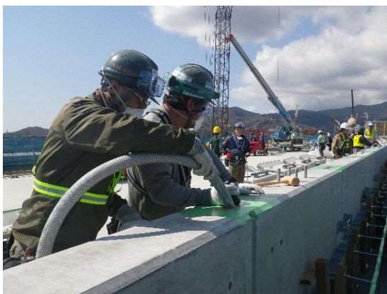
写真-1.2.3 充填ホースの差し込み状況
