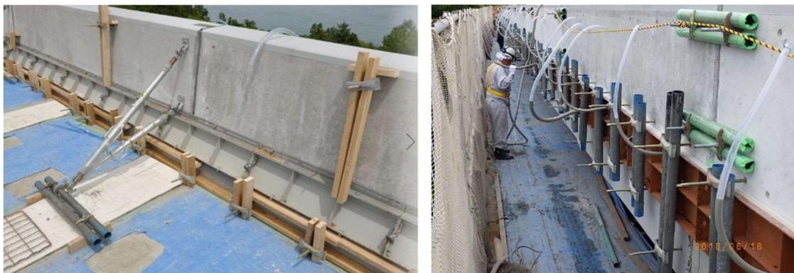
(a) 前面型枠設置例（木枠+鋼枠）
