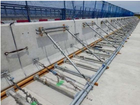
写真-1.2.1 前面型枠の設置状況例
