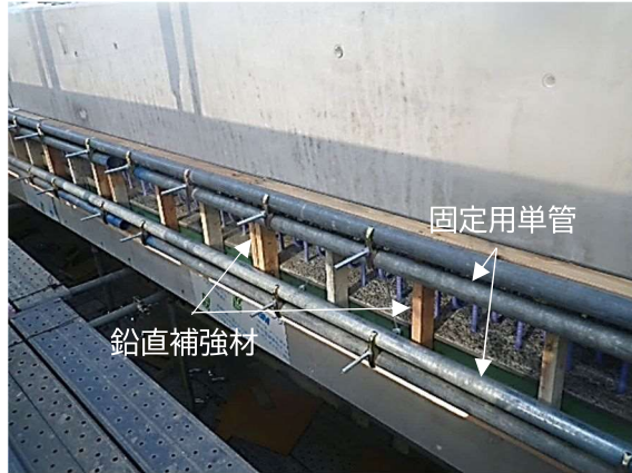
写真-1.2.2 背面透明型枠の設置状況例
