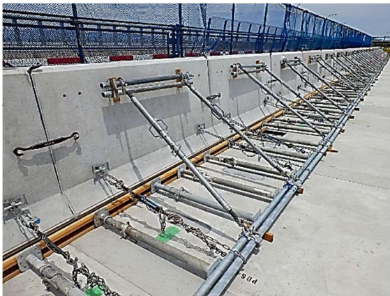
写真-1.2.1 前面型枠の設置状況例
