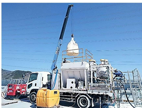
(a) フレコンバッグによる材料投入状況
