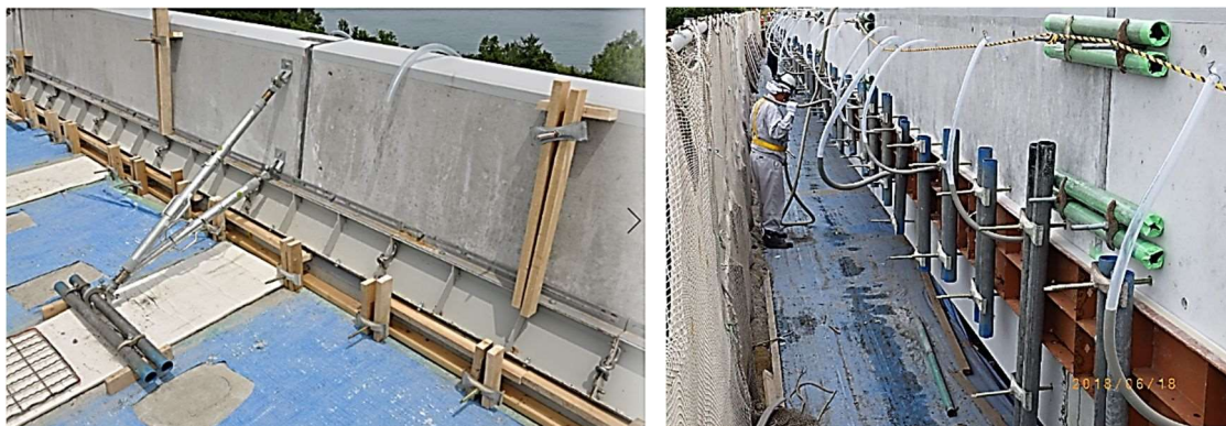
(a) 前面型枠設置例（木枠+鋼枠）
