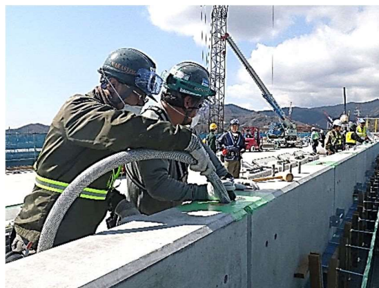
写真-1.2.3 充填ホースの差し込み状況
