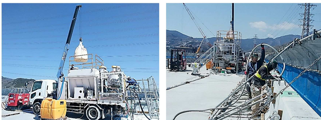
(a) フレコンバッグによる材料投入状況
