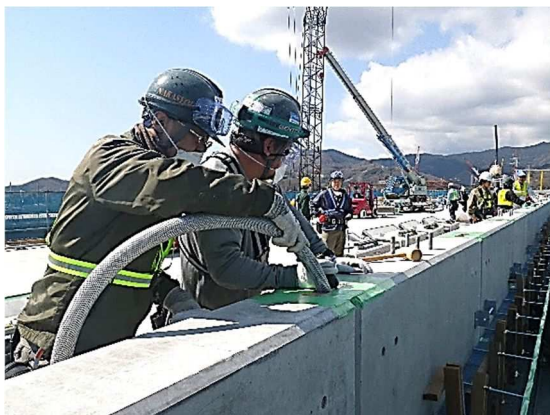
写真-1.2.3 充填ホースの差し込み状況
