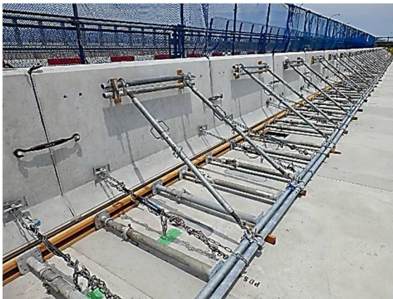
写真-1.2.1 前面型枠の設置状況例
