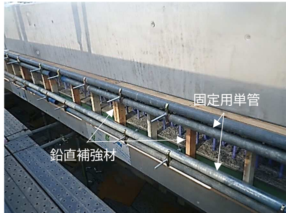
写真-1.2.2 背面透明型枠の設置状況例
