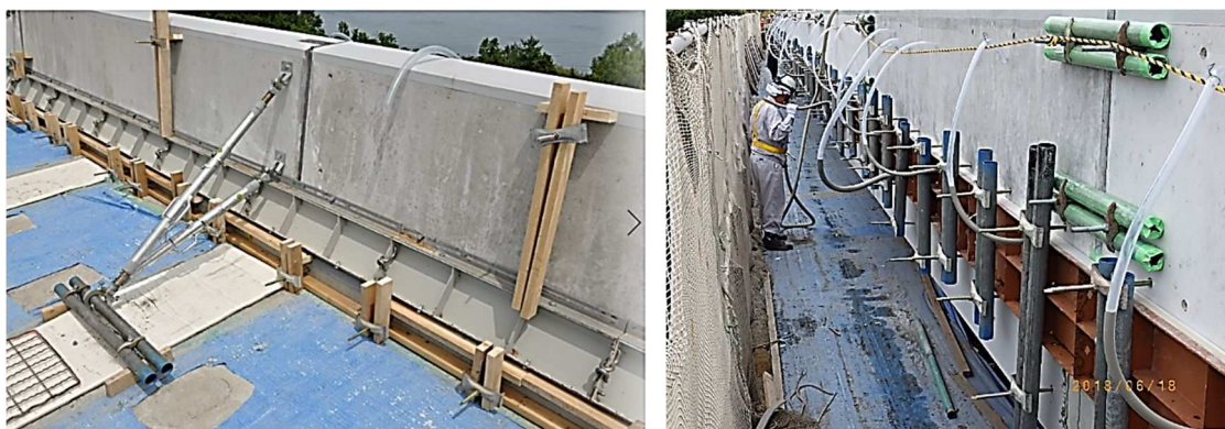
(a) 前面型枠設置例 (木枠+鋼枠) (b) 背面型枠設置例 (鋼枠) とエア抜き例
